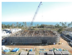
OWTF建設現場外観
