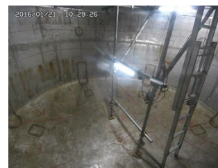
再処理特別研究棟 内側タンク胴部の撤去 撤去後
