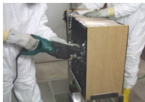
高減容処理施設における HEPAフィルタ等の減容化
